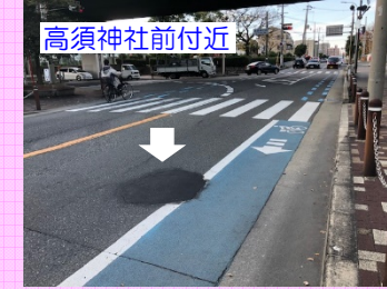
騒音・運転ミスに繋がる道路の大きな凹みを応急修繕
