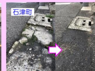
荒れてガタガタになった路面を緊急補修。
