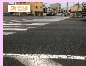
大型車の通行の度に振動を起こしていた路面の凹凸を舗装。
