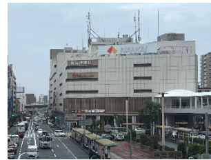
高架化に伴い駅ビルの更新も必要
